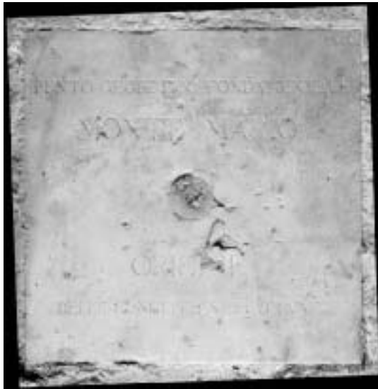
Fig. 4 – Lastra posta alla base della torre tronco-conica testimoniante il punto d'inizio delle longitudini italiane: coordinate WGS84 41^{\circ}55'25'' N, 12^{\circ}27'08'' E; coordinate Roma40 41^{\circ}55'26'' N, 0^{\circ}00'00'' E, altitudine 137.85 m s.l.m. (Autorizzazione Ministero della Difesa prot. 867/031-507 del 26 marzo 2004).
