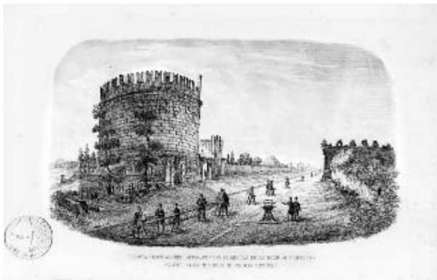
Fig. 2 – L'inizio delle operazioni di misurazione della base della Via Appia presso il monumento di Cecilia Metella. Si notano i cinque cavalletti dotati di microscopio e la tesa poggiata sui primi due cavalletti. L'incisione è tratta da A. SECCHI, Misura della base trigonometrica eseguita sulla via Appia ... Roma, 1858 (Roma, Biblioteca Casanatense, L.I.73 CC).
