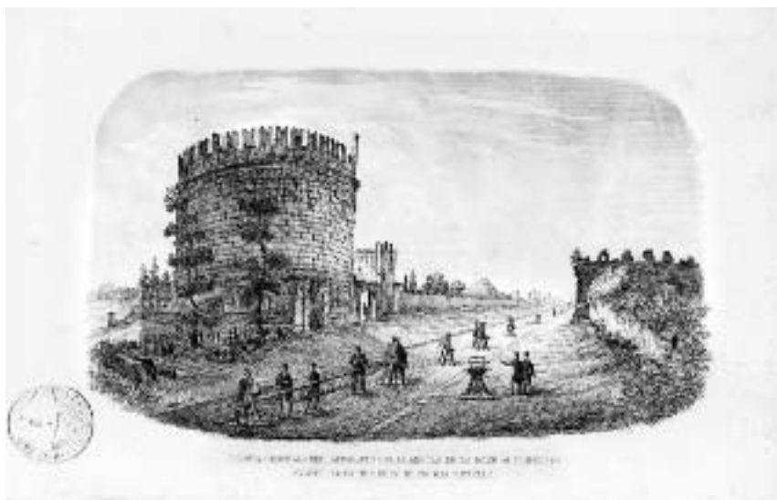
Fig. 25 – Misura della base geodetica sulla via Appia presso il monumento di Cecilia Metella.
