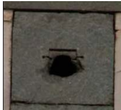
Particolare del foro in facciata. Sono presenti i segni dell'antica presenza di una laminetta di metallo.
