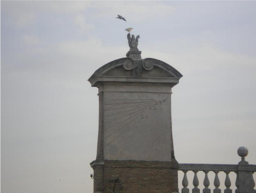
Fig. 8 L'orologio di controfaçciata Nord Est solo per le ore estive 21, 22 e 23 precedenti il tramonto; infatti non ha la linea meridiana verticale, ma solo l'equinoziale. La foto presa prima del tramonto nell'inverno 2012, anno del quarto centenario di Clavio, non ha l'ombra dello stilo, perché la luce del Sole in inverno batte sul semipiano dietro, quello che dà sulla piazza.
